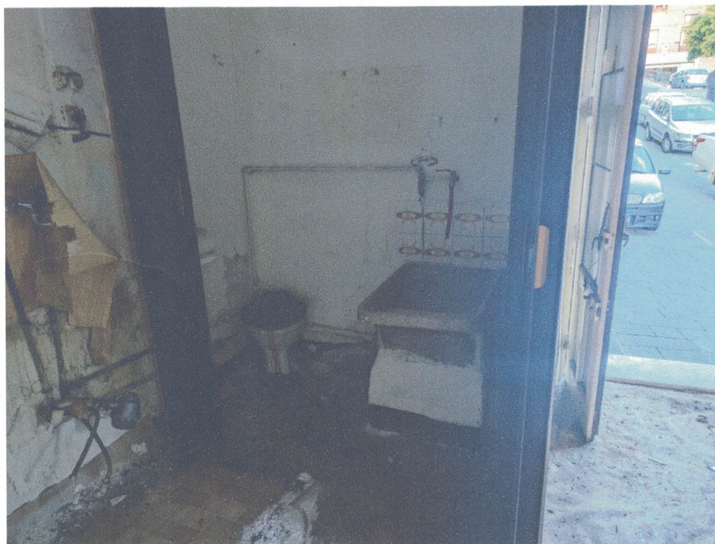
FOTO 10- Angolo wc ricavato in una porzione del vano 1 dell'u.i.u. di C.le Flora n. 1
