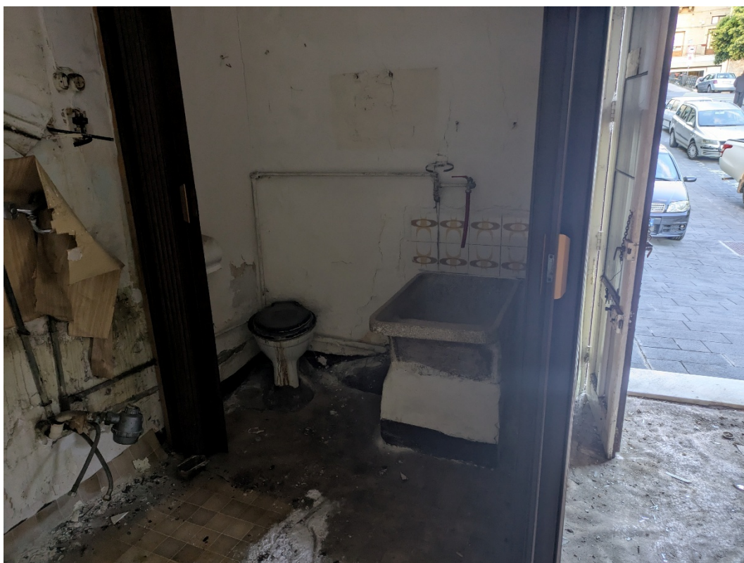
FOTO 10- Angolo wc ricavato in una porzione del vano 1 dell'u.i.u. di C.le Flora n. 1
