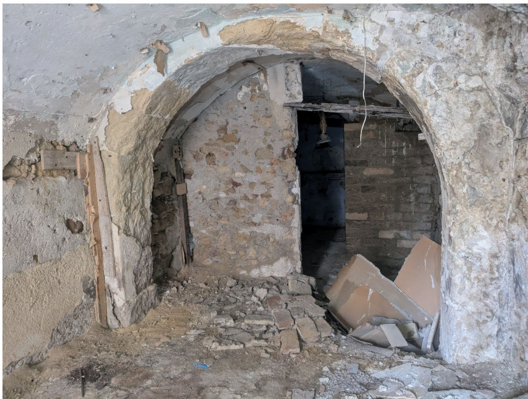
FOTO 9- Cedimento pavimentazione u.i.u. Via Calatafimi n. 13
